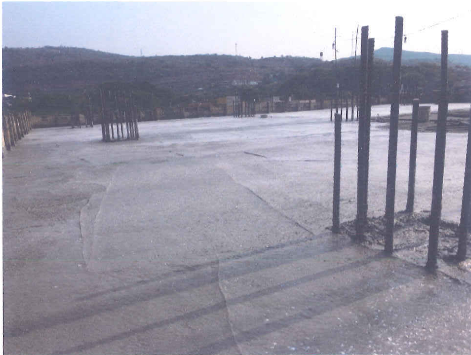
Fundición de losa segundo nivel Edificio Administrativo.
