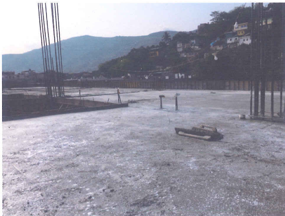
Aplicación de anti sol en Losa del edificio administrativo.
